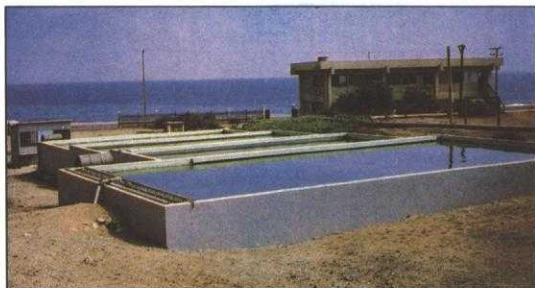
Este proyecto experimental utiliza algas y los rayos del sol para matar las bacterias patógenas en las aguas cloacales.
