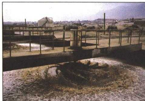
La actual planta de depuración de aguas cloacales en Antofagasta.
