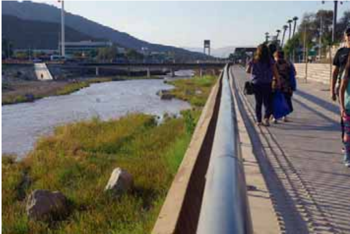
Entre las obras se hizo un encauzamiento del río Copiapó para proteger a las personas ante sus eventuales subidas.
