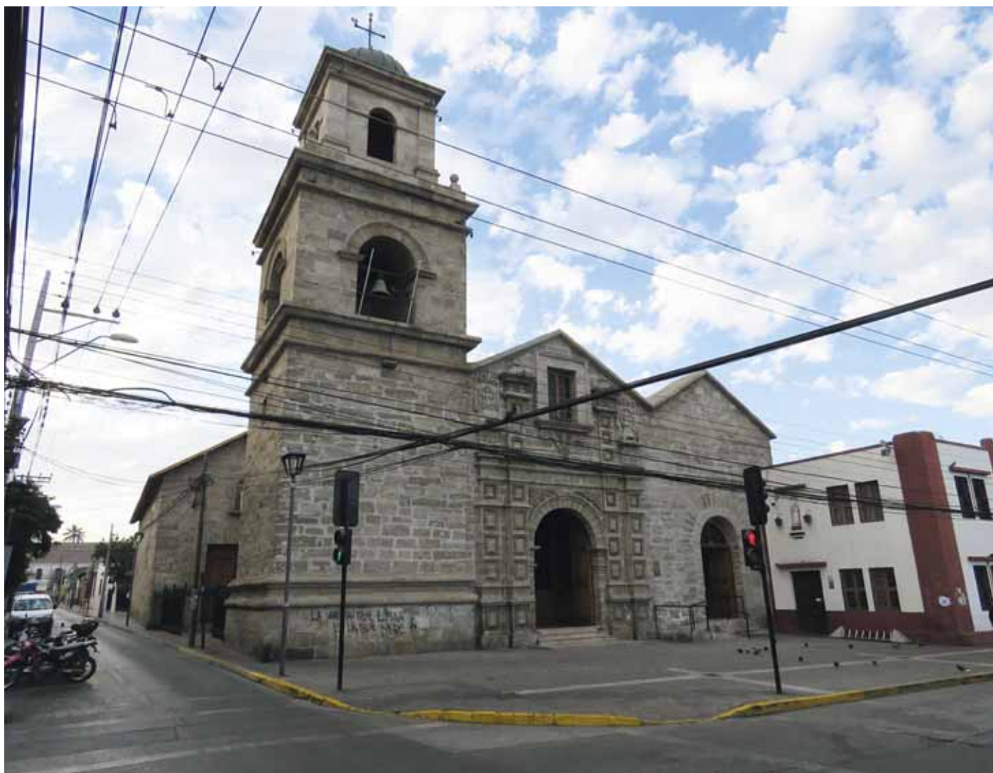
La Iglesia de San Francisco, de estilo neoclásico, es el único templo que sobrevivió al incendio de La Serena, provocado por el pirata Bartolomé Sharp en 1680.
