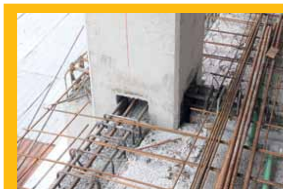
El sistema de unión viga-columna aportaría una unión de acero que cumpliría las exigencias de diseño estructural sin costar de más, junto con favorecer la arquitectura ya que no presentaría consolas de apoyo, a diferencia del prefabricado tradicional. Una vez ejecutadas las vigas se instalan las losetas.
