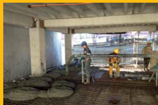
Se procede a montar las vigas en las columnas. Después de las vigas se instalan las losetas. Luego se instala la malla electrosoldada y la armadura superior de las vigas que atraviesa las columnas. Posteriormente se montan los ductos de instalaciones que van embebidos en la losa y, con todo el tejido listo, finalmente se procede con el hormigonado de la sobrelosa estructural.
