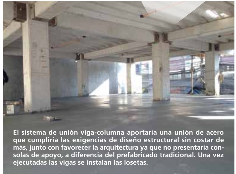
Los 19 pilares de 15 metros cada uno fueron fabricados con antelación en un ambiente controlado y con una calidad superior a la que tendría si su construcción fuese in situ. Luego fueron transportados hasta la obra.
