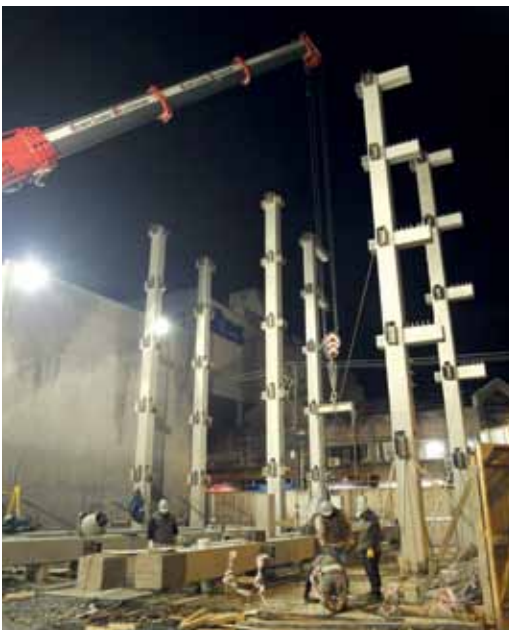
El montaje se llevó a cabo en la noche, debido a que el alto flujo vehicular durante el día dificultaba el traslado de los pilares. Primero, con la ayuda de una grúa de alto tonelaje, se levantan las columnas, cuya base se empostra en un cáliz ubicado en la base.
