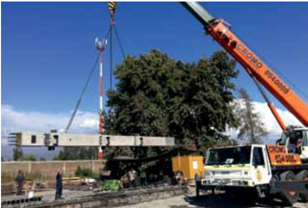
Los 19 pilares de 15 metros cada uno fueron fabricados con antelación en un ambiente controlado y con una calidad superior a la que tendría si su construcción fuese in situ. Luego fueron transportados hasta la obra.
