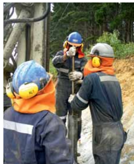
FOTOS GENTILEZA ACCIONA INFRAESTRUCTURAS
