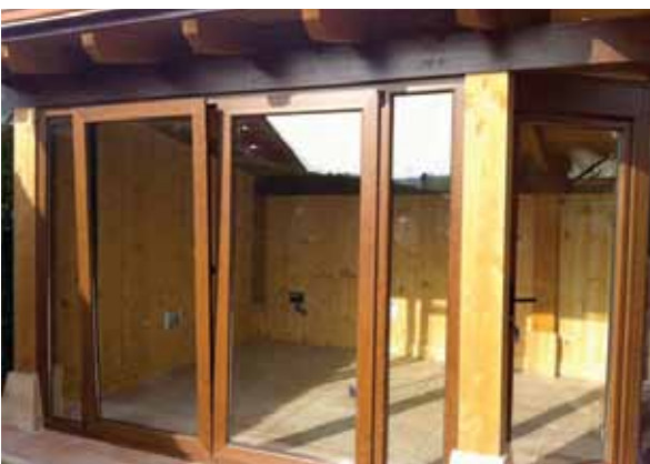
Ventanas de aperturas oscilobatientes cuenta con un perfil línea europea triple cámara térmica, unión esquinas 45° termo fusionado y un colector de condensación integrado, además tiene un marco perimetral de 50 milímetros.
