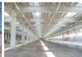
TALLERES Y COCHERAS SAN EUGENIO - METRO LINEA 5
