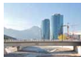
VIGAS PUENTE COSTANERA CENTER
