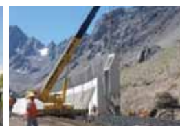
COBERTIZO RUTA 60 CH CRISTO REDENTOR
