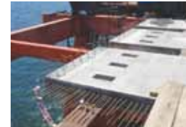
LOSAS MUELLE GNL QUINTERO
