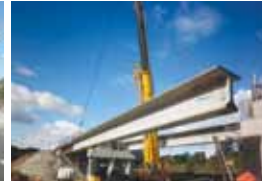
28 ESTRUCTURAS RUTA 5 SUR PUERTO MONTT - PARGUA
