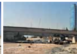
VIGAS PUENTE COSTANERA CENTER
