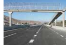
10 PASARELAS EN RUTA 5 NORTE VALLENAR - CALDERA
