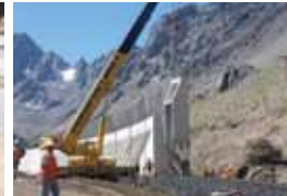
COBERTIZO RUTA 60 CH CRISTO REDENTOR
