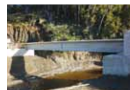
PUENTE HUELDEÁN CHILOE
