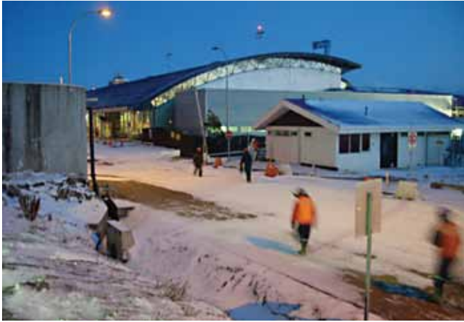
Ampliación del Aeropuerto de Punta Arenas, Julio 2011.
