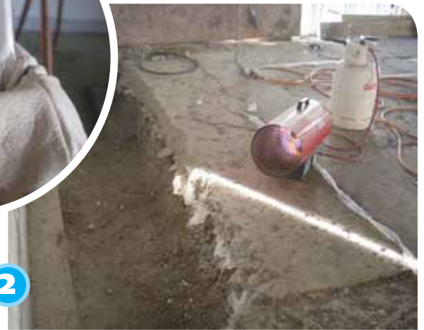
Uso de calefactor de cañón a gas para aumentar la temperatura a 20°C.
