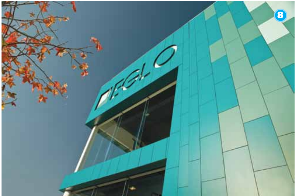
8. Instalación de fachada ventilada finalizada.
