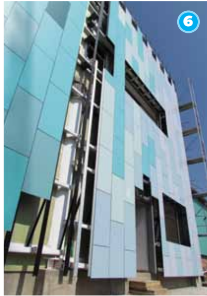
6. Fijación y plomo de placas.
