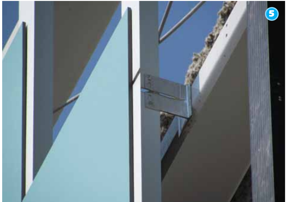
5. Detalle de las fijaciones inmóviles y las placas montadas.
