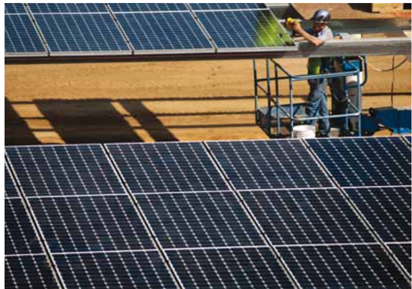
Para la generación de energía, se instalaron una serie de paneles fotovoltaicos de cuatro megavatios, sobre las áreas de estacionamientos del recinto.
