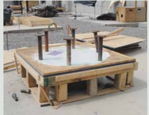
Sobre el aislador elastomérico se instala el moldaje y enfierradura del capitel.
