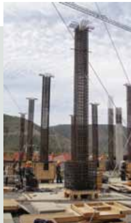
A medida que se avanza con la enfierradura de los pilares, se comienza a hormigonar la losa del piso y los pilares.
