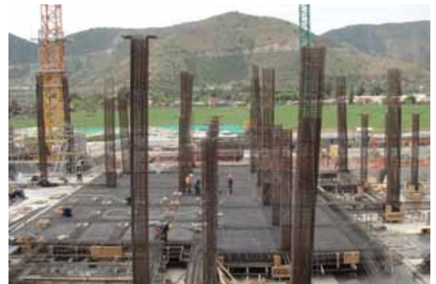
A medida que se avanza con la enfierradura de los pilares, se comienza a hormigonar la losa del piso y los pilares.
