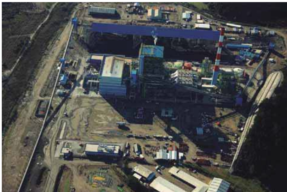
El Complejo Santa María de Coronel está emplazado en una superficie de 10 hectáreas y se apresta a generar 700 MW.
