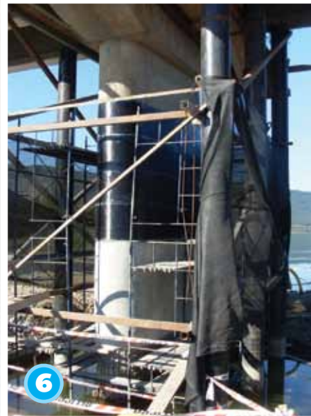
Vista general del puente con refuerzo en base a fibras de carbono Tyfo
