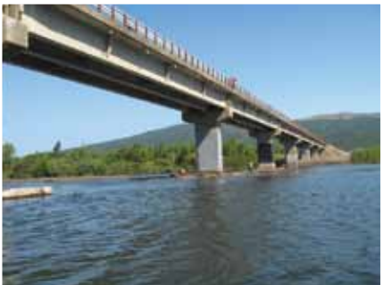
Vista general del puente con refuerzo en base a fibras de carbono Tyfo
