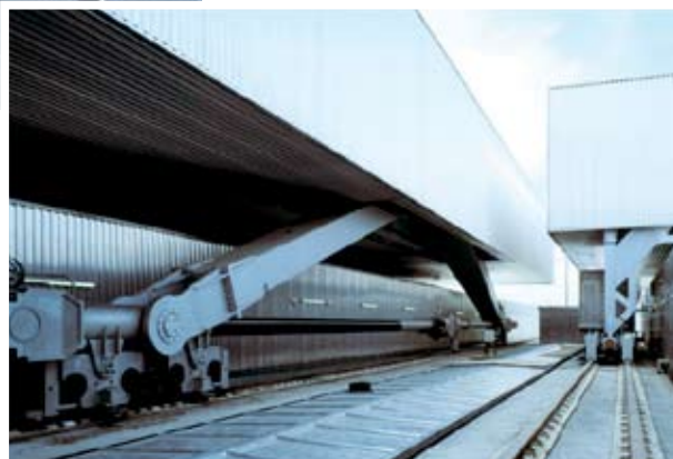
GENTILEZA FCC CONSTRUCCIÓN
