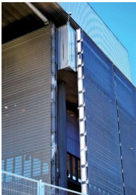
Los cerramientos metálicos de panel tipo sándwich permiten que el edificio filtre la luz del sol.
