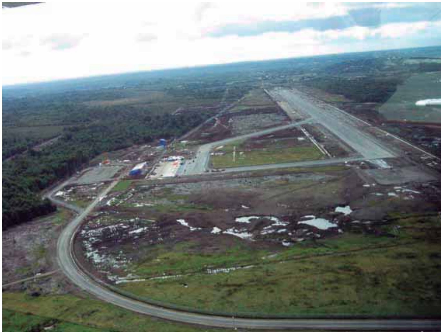
Vista aérea, etapa inicial de la obra.
