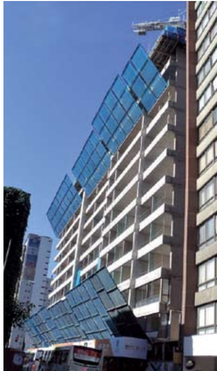
GENTILEZA EURO CONSTRUCTORA
