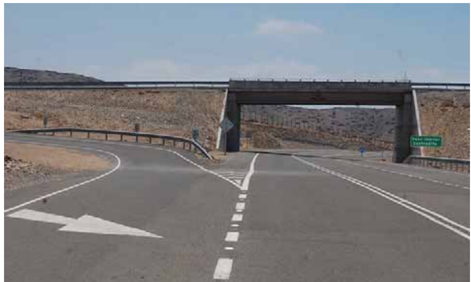
Una de las salidas de la ruta: Paso interior Quebradita.
