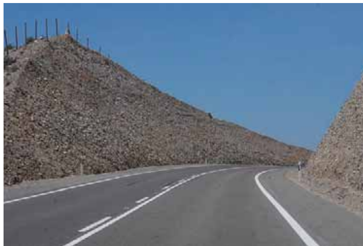
Vista general doble vía Vallenar-Caldera.
