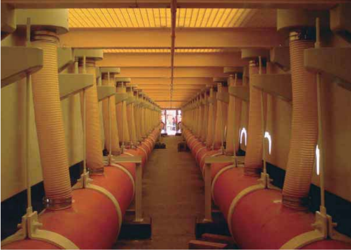
En su interior, la planta aloja mecanismos de extracción de cobre, los que son transportados hasta la planta chancadora.
