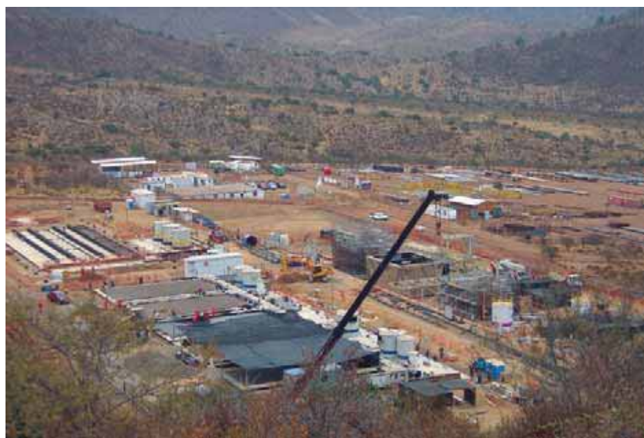
La planta Tres Valles, provincia de Choapa, vista en altura.
