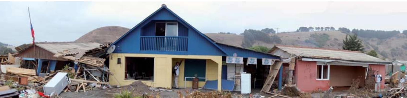
▲ Las viviendas de distintas materialidades sufrieron daños variables. A la izquierda, vivienda de madera con daño grave; en el centro, casa de mampostería con daños menores; a la derecha, vivienda de adobe con daño moderado.
