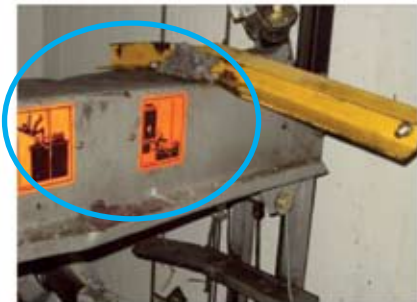
La suspensión de la cabina del ascensor quedó resentida por el impacto
