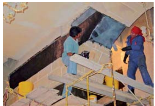
Retrofit a la Iglesia de Nobsa, en Colombia. Se hizo un reforzamiento de los muros con tejido de fibra de carbono SikaWrap 300C.
