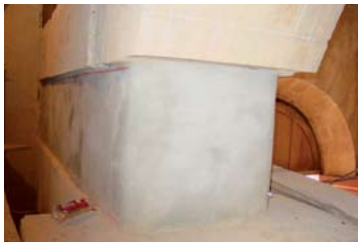
Retrofit a la Iglesia de Nobsa, en Colombia. Se hizo un reforzamiento de los muros con tejido de fibra de carbono SikaWrap 300C.
