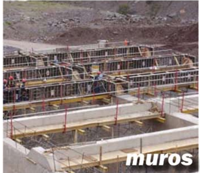
OBRA DESARENADOR AZUFRE HIDROELECTRICA LA HIGUERA
