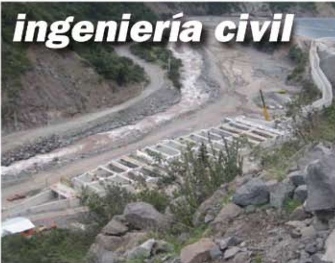
OBRA DESARENADOR AZUFRE HIDROELECTRICA LA HIGUERA
