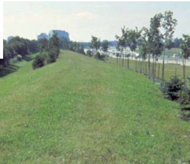
DIQUE DE TIERRA
