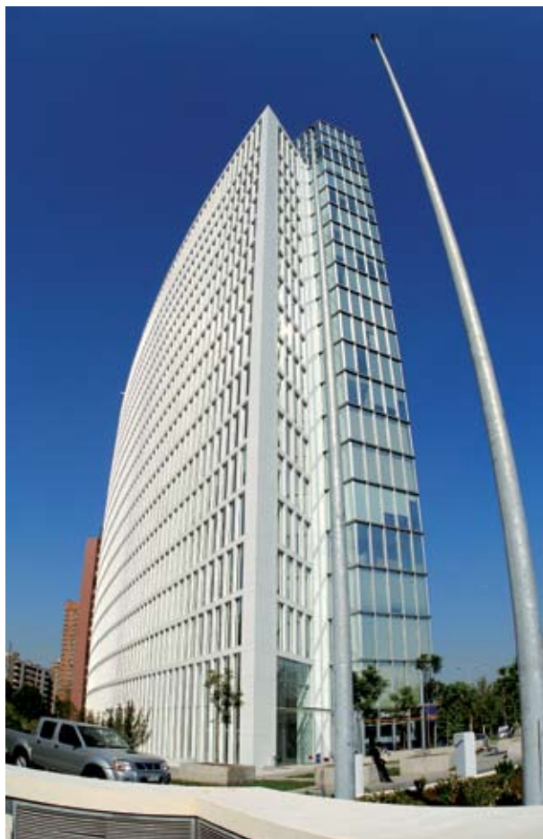
Detalle de la fachada sur. En ella los muros cortina ostentan una superficie más pétreo.
