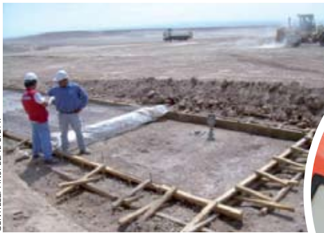
Control de densidad en terreno por medio del método del cono de arena. A la derecha, densímetro nuclear.
