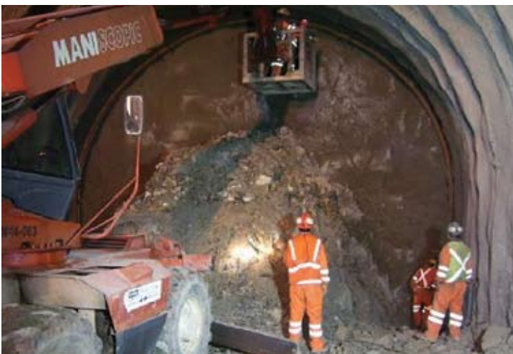
Túnel San Cristóbal: Tecnología y productividad, claves para disminuir plazos.
