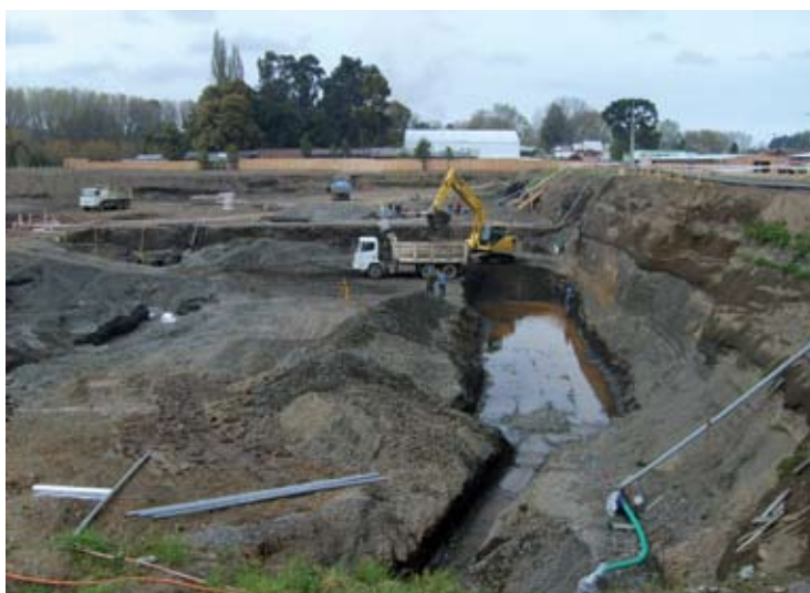
La napa se superó agotando el terreno durante seis meses con bombas sumergibles. Tras la excavación, los rollos de membrana se colocan entre el emplantillado y la losa de fundación.
