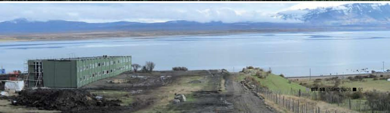
Para no invadir el paisaje existente y por un tema de seguridad ante incendios, los techos de los edificios poseen una capa vegetal de césped de 30 centímetros.
