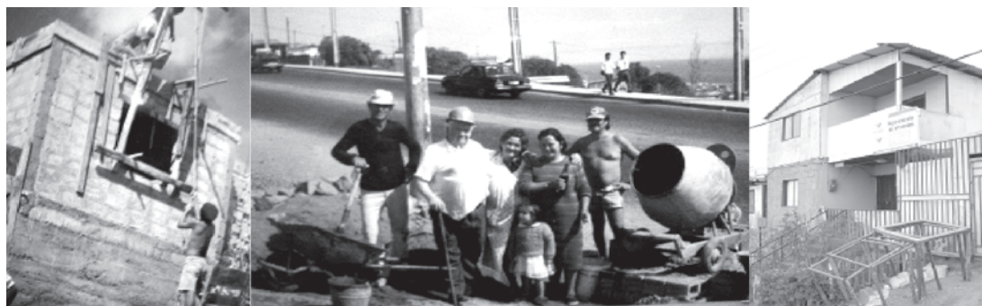
Participación de la familia en proceso de autoconstrucción, izquierda y centro fotografías año 1985, derecha, vivienda en 2005, Población René Schneider Sur, Antofagasta, Chile ▶ 18
