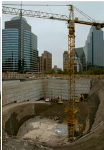
La técnica de excavación “muros bajando”, utilizada en Titanium La Portada, consiste en anclar los muros hacia el terreno, los que a su vez sirven de pilas de sostenimiento.
