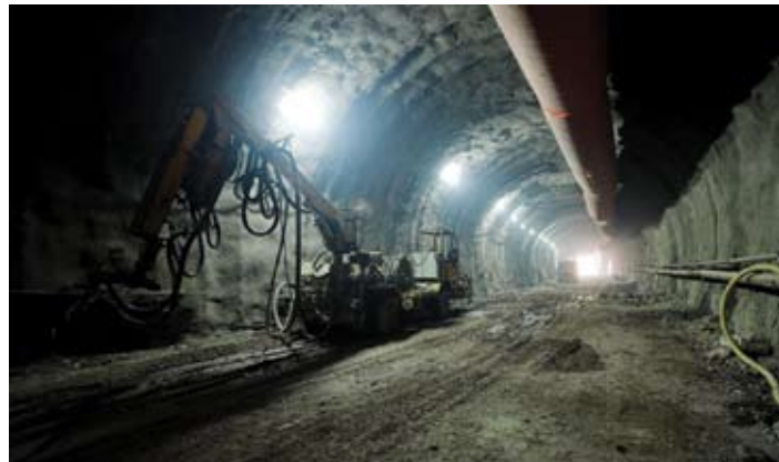
Los túneles se fortifican a través de la aplicación de shotcrete de espesor mínimo de 5 cm y la colocación de pernos de anclaje. Faenas en el sector norte.
