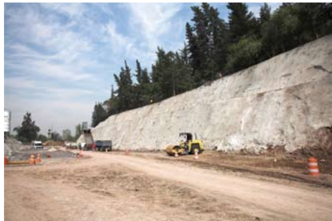
Ejecución de faenas y accesos en el sector sur del túnel San Cristóbal.
