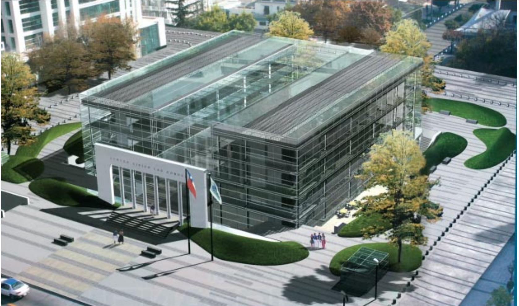
La estructura del nuevo edificio será de hormigón y estará completamente cubierta por una fina piel de cristal que le proporcionará luz a las oficinas y servicios del nuevo Centro Cívico.
