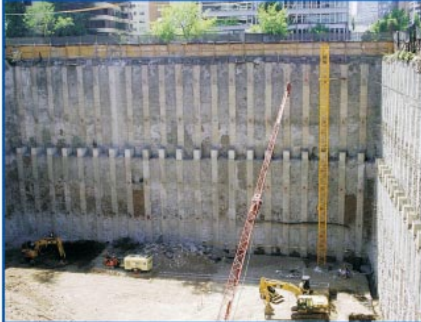
Anclaje Edificio Territoria 3000
