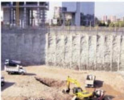
Pilotes y Anclajes Edificio Mistral Las Condes
