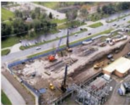
Pilotes y Anclajes Edificio Parque Araucano
