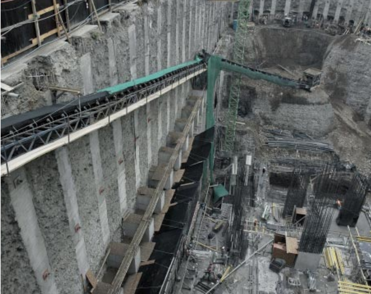
Para retirar la tierra se recurrió a una cinta transportadora anclada a las pilas de entibación. Una solución «importada» de la industria minera.
