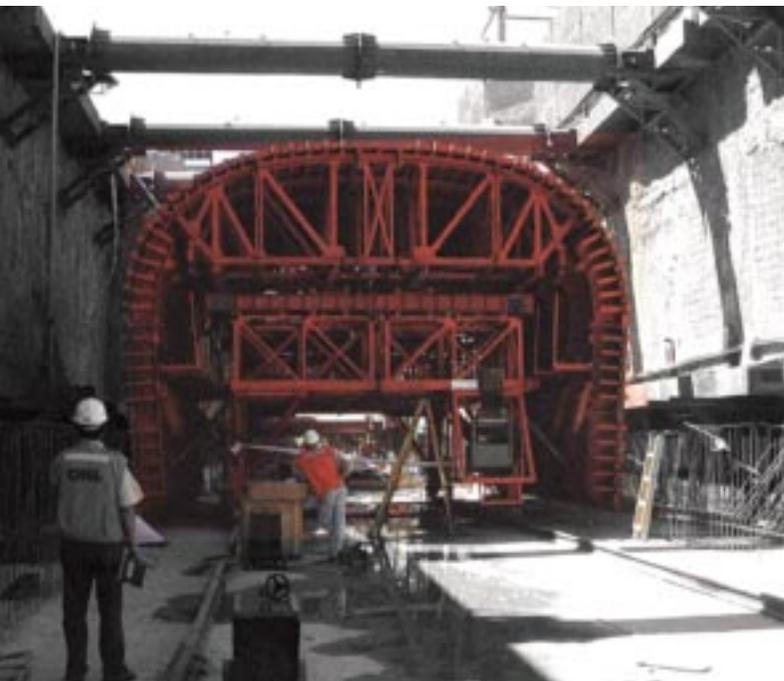
La constructora OHL diseñó una máquina especial para el hormigonado del túnel, fabricada en Europa y montada en el lugar de la faena. Se obtuvieron altos rendimientos
