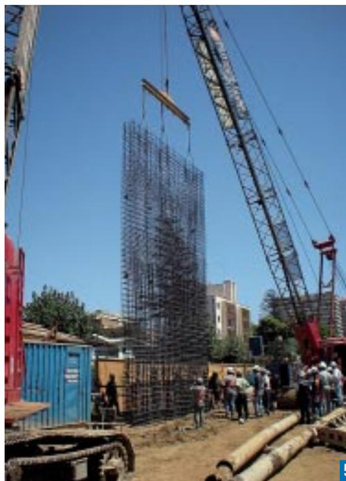
Pared moldeada. Primero se realiza un muro guía de 1 metro de profundidad (fotos 1, 2 y 3). A continuación se realiza la excavación con maquinaria tipo «clamshelles» y se aplica bentonita en suspensión para dar estabilidad a las paredes (foto 4). Luego se coloca la enfierradura de acero (foto 5) y finalmente se hormigona.
