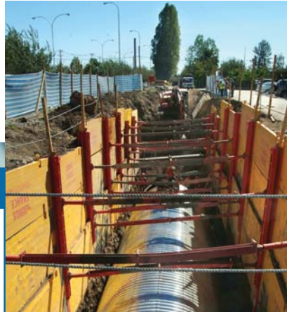
COLECTOR COLOMBIA. Las bóvedas corrugadas se conforman por pequeñas planchas enlazadas dentro de las zanjas a través de pernos. En esta zona las profundidades son de 7 a 8 metros.
