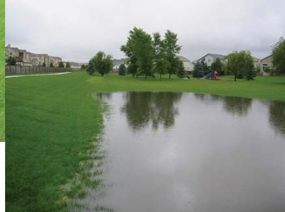
Estanque de regulación. El parque, que normalmente permanece seco, almacena y controla el escurrimiento de aguas lluvia por medio de esta solución.
