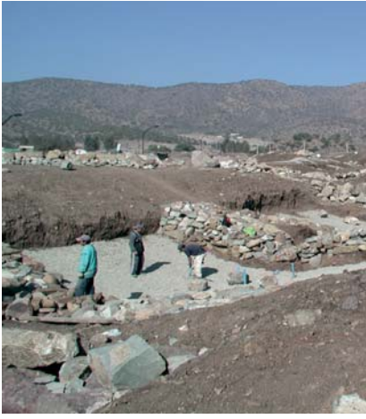
PROYECTO LA RESERVA, Colina. Construcción de la quebrada ON2, colocación de emplantillados y material de filtro en cuencos de disipación.
