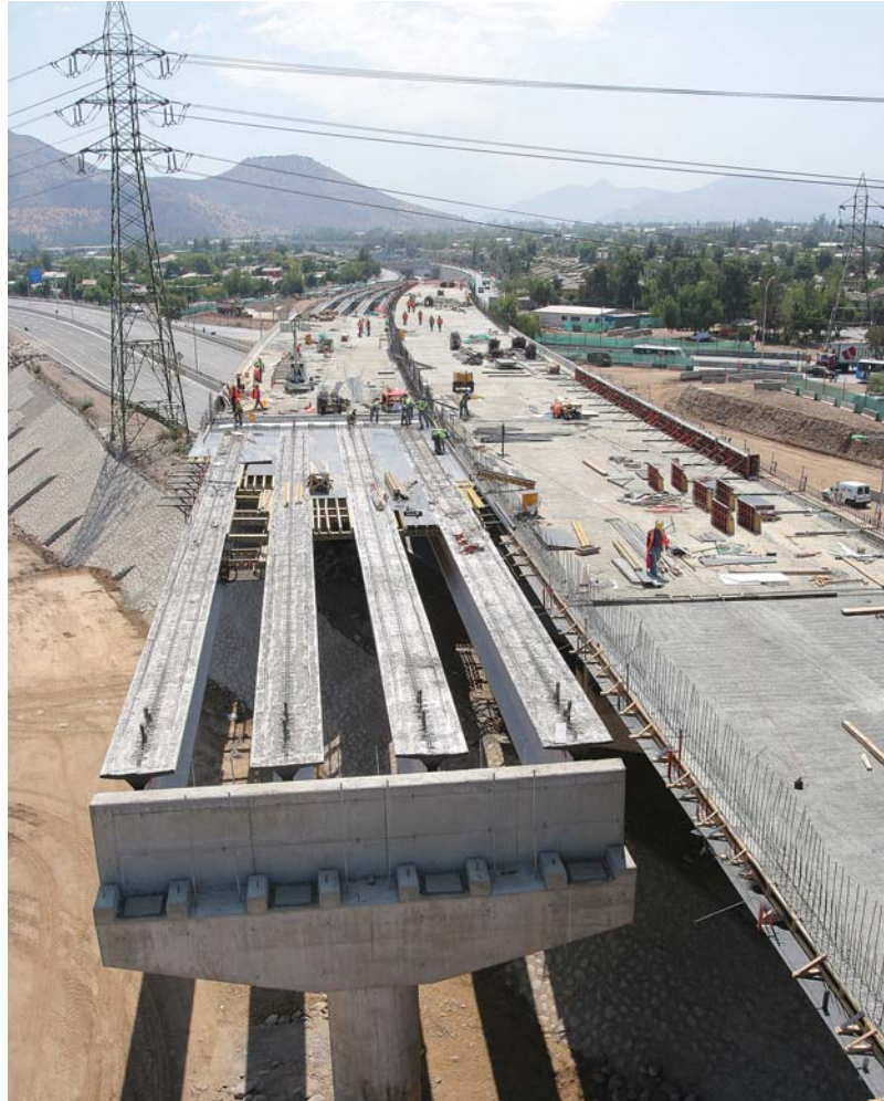
El puente cuenta con 16 cepas que forman 17 vanos, los que se salvan con vigas (8 vigas por vano).
