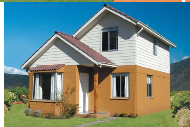
Hoy: Casa de dos pisos combinación ladrillo y plancha de fibrocemento. Marcos de ventanas de PVC, más áreas verdes y mejor distribución del espacio.
