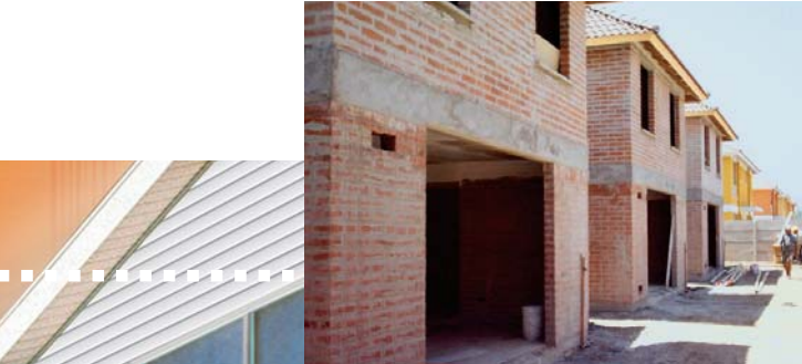
Proyecto en construcción Aconcagua.
